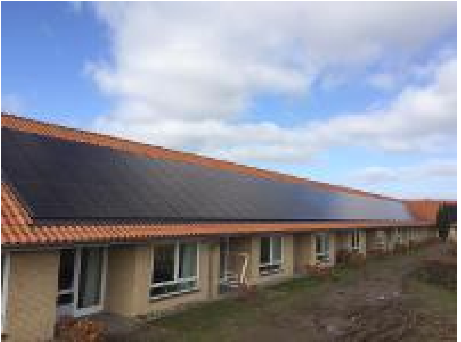
Solceller på Tandsbjerg Plejecenter
