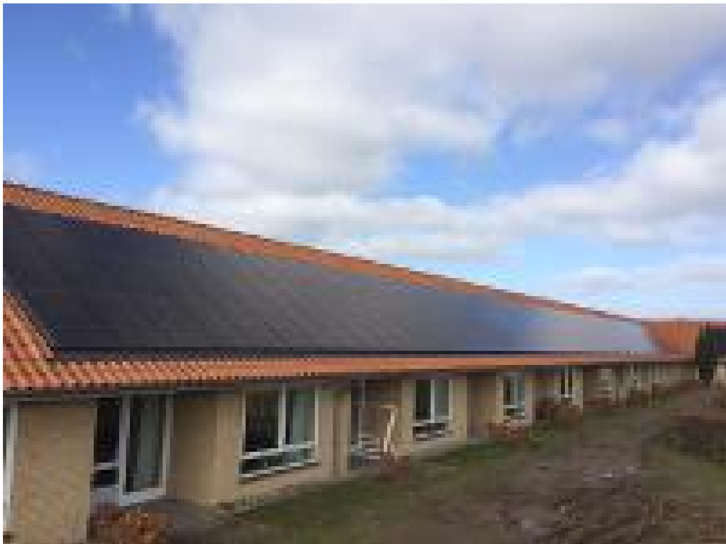
Solceller på Tandsbjerg Plejecenter
