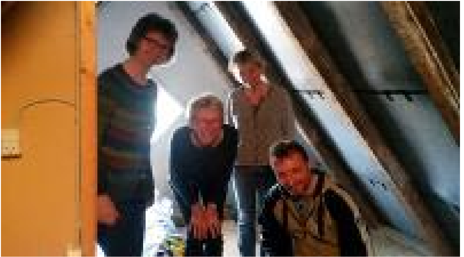
Kvinderne og energivejleder, Jan Gregersen fra SIB, tjekker isoleringen på loftet.
