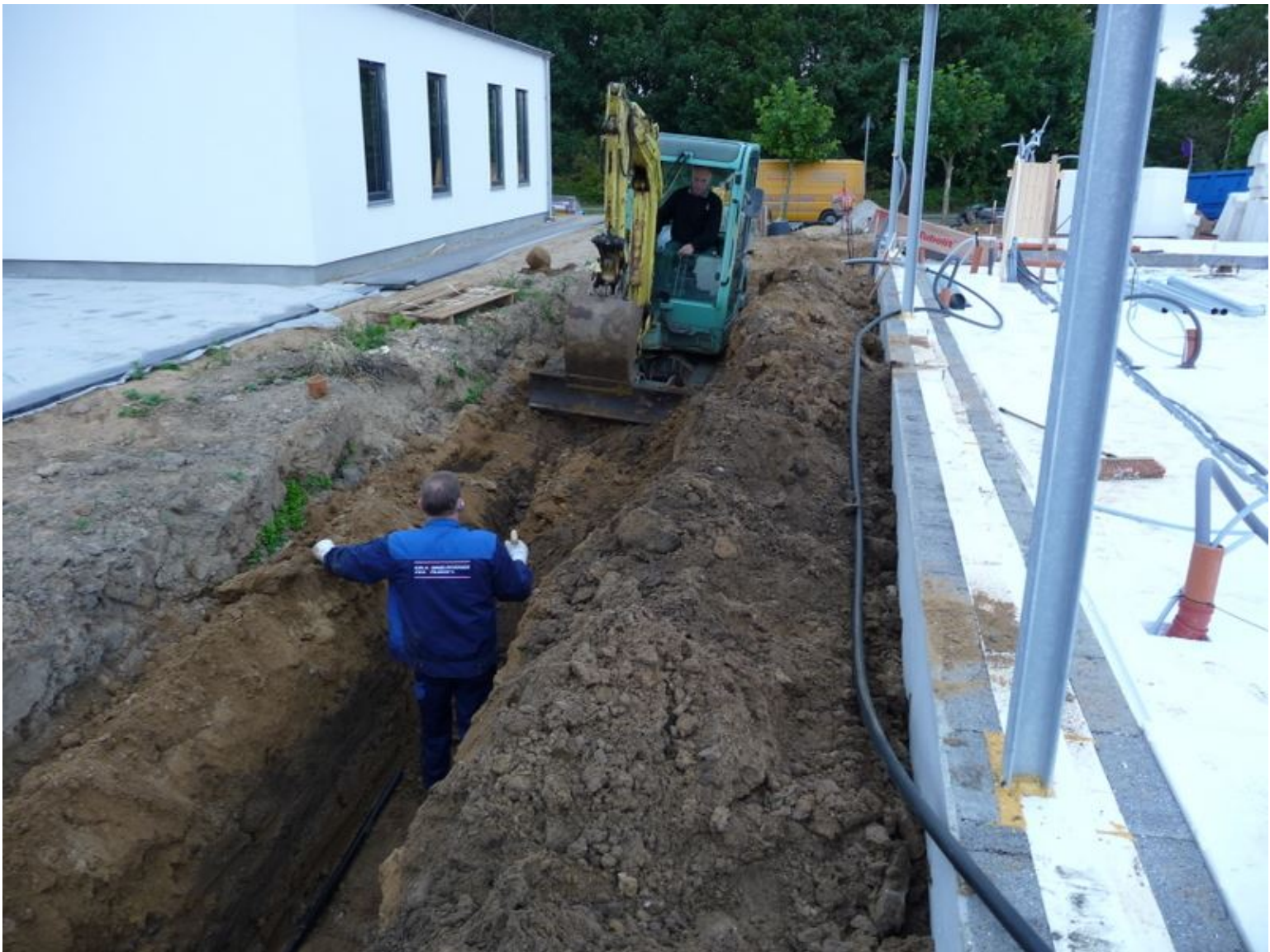
Nedgravning af jordslanger til varmepumpe og luftforvarmning.
