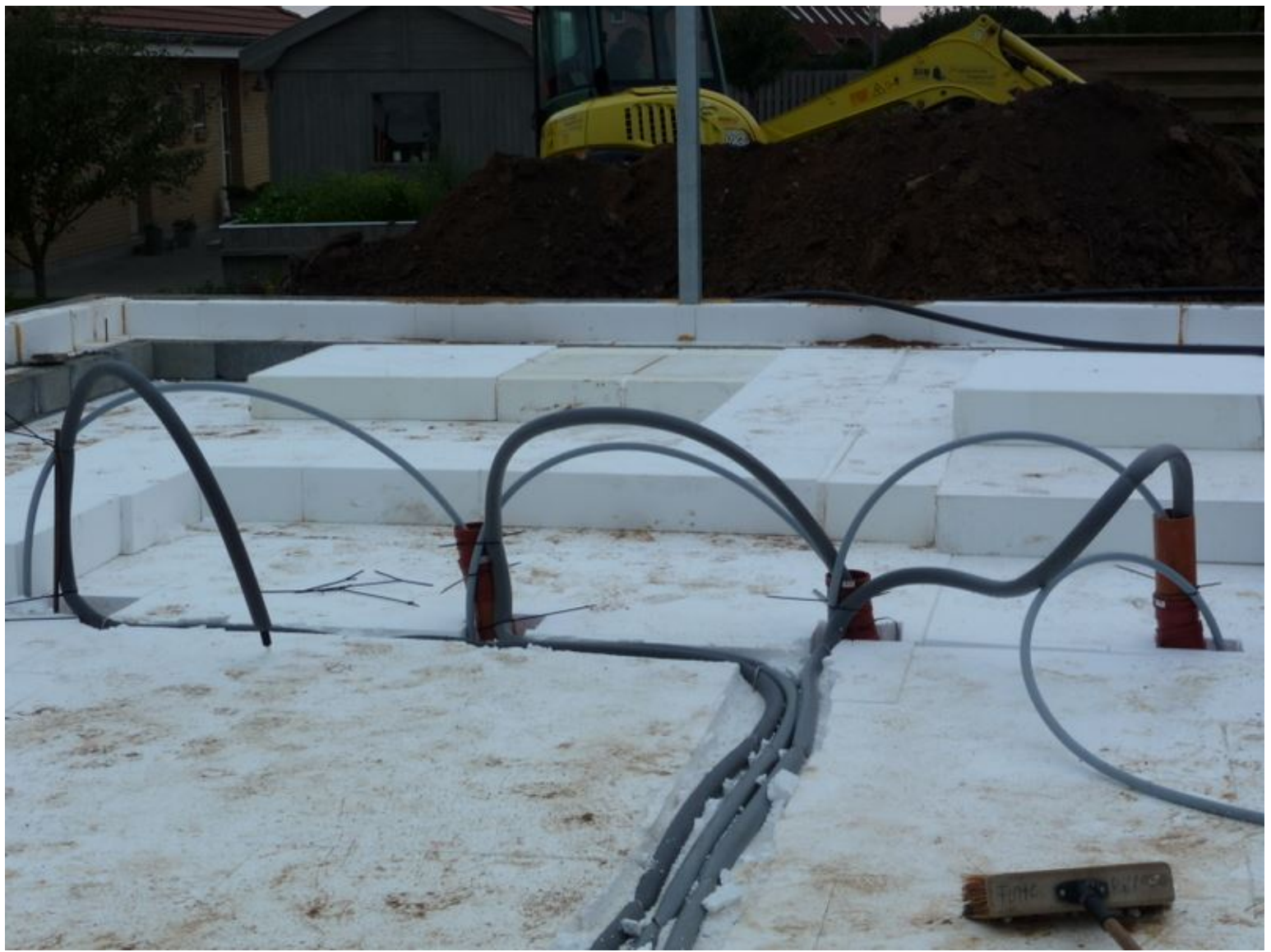
De sidste 200 mm isolering udlægges for at opnå en samlet isoleringstykkelse på 600 mm.
