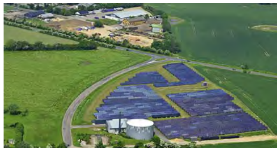
Mens byggeriet stadig var i gang.
